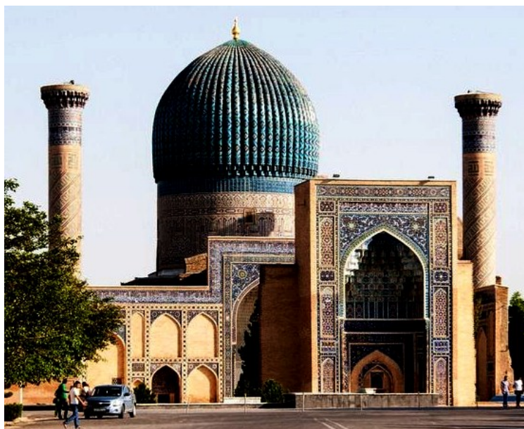
Фото № 14. Главный фасад мавзолея Гур-Эмир в настоящее время.
